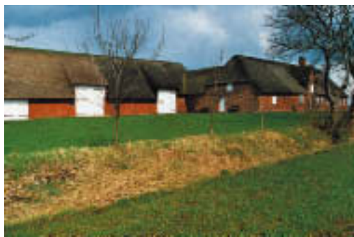
Fig. 4.46: „Uthländisches Haus“ „In die 5 gebaut“ extended by barns, built like „5“ utilization: membership corporation of North-Friesland
